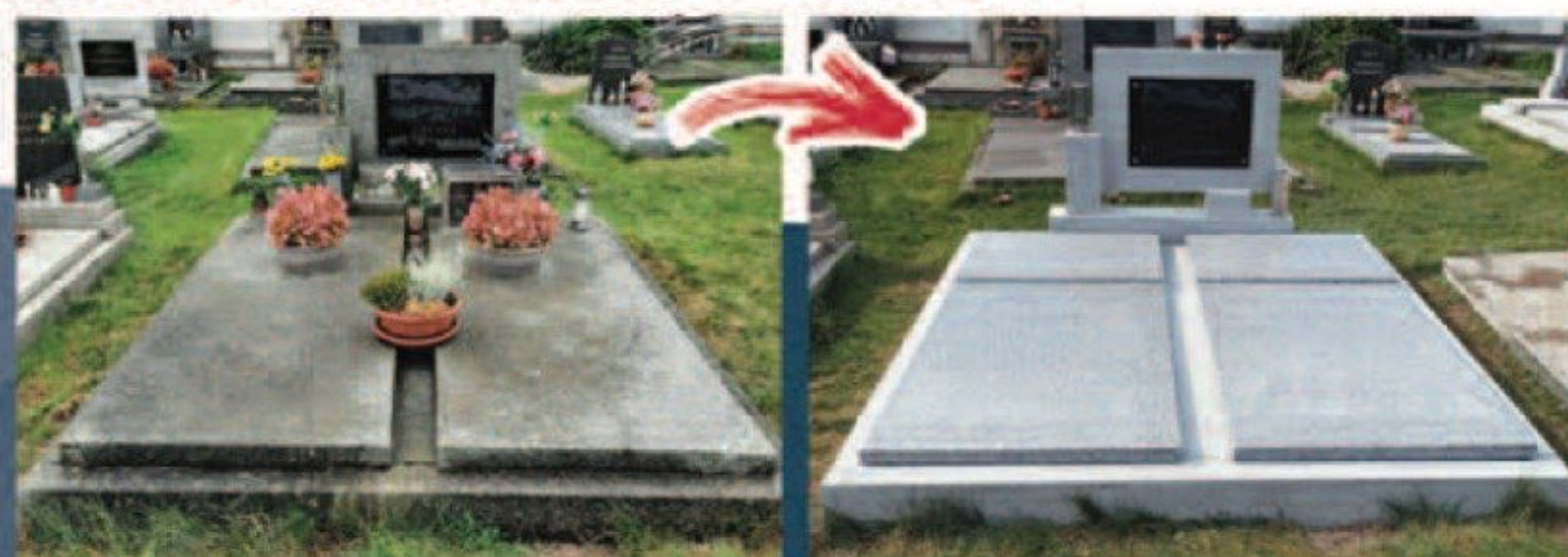
Ukázka realizace: broušení teracových rámců a výměna desek za žulové.
